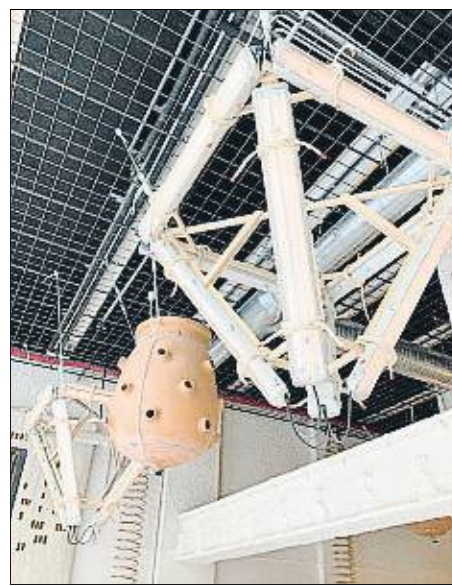
Sistemas de refrigeración e iluminación
